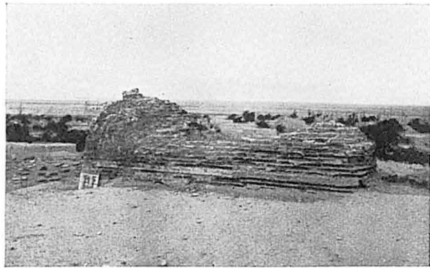
Fig. 7. — Ruine de la voûte de l'iwan.
