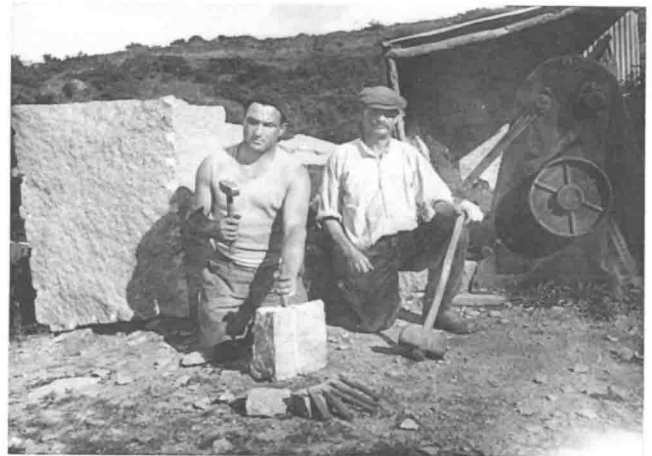
Fig. 5. — Dièlette (Manche). Extraction moderne du granit dans une petite carrière; bloc à rainures et entailles, outils employés (M. Pillet, août 1933).
