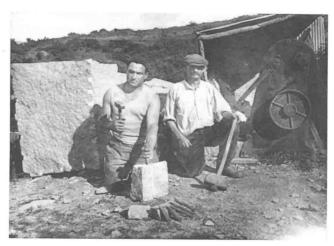
Fig. 5. — Diélette (Manche). Extraction moderne du granit dans une petite carrière; bloc à rainures et entailles, outils employés (M. Pillet, août 1933).
