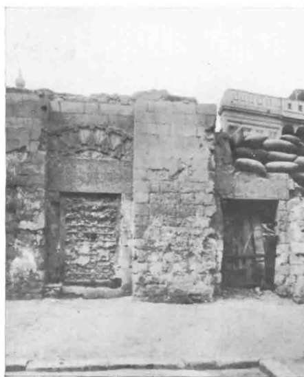
c. — Vestiges de la mosquée de Beïbars (chârî' an-Nahassin).
