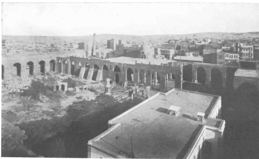
a. — Vue d'ensemble de la cour de la mosquée d'al-Hâkim.
