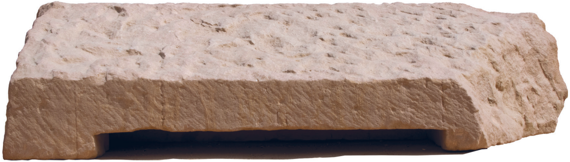
ABB. 2. Rückseite und gewölbte Oberseite des Türsturzes. Foto: H. Kockelmann.
