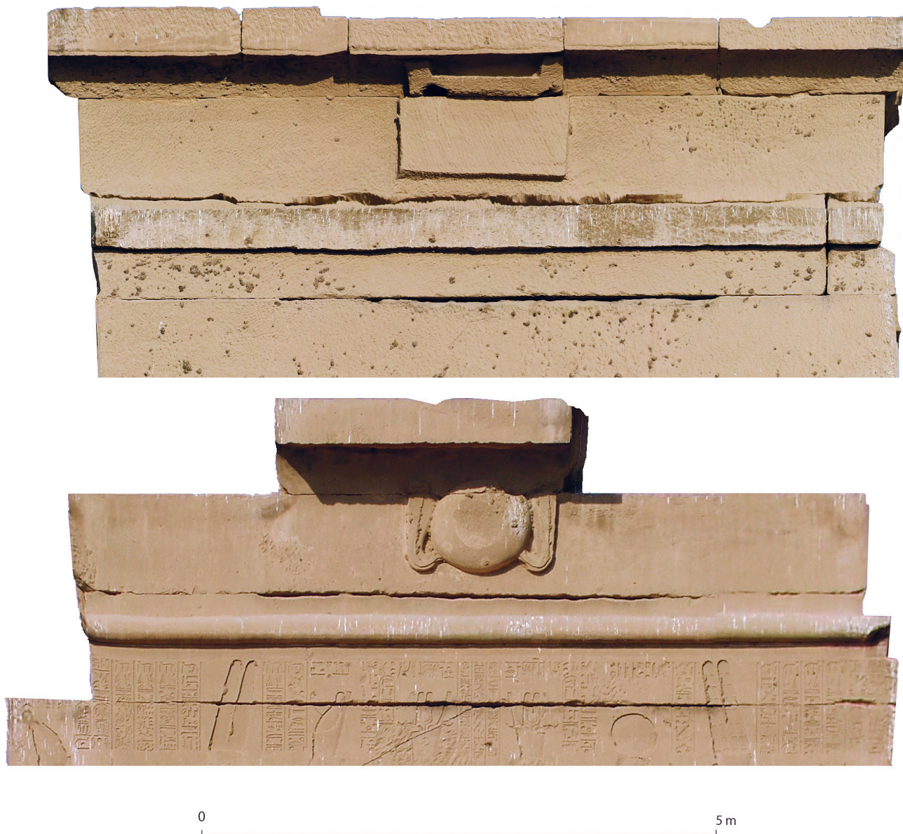
FIG. 15. Corniches inachevées de la porte de l'Est à Karnak. Ces exemples montrent deux états différents de la préparation d'une corniche par les tailleurs de pierre. La gorge de la première est épannelée mais n'est pas encore ravalée, et une réserve de matière est conservée à l'endroit du disque et des urai . Le boudin n'est quant à lui pas encore taillé. La seconde corniche, quant à elle, est prête à être décorée. On remarquera très clairement ici, en l'absence de réserve de matière, que les ailes ne sont pas en rond de bosse mais taillées dans le creux.
