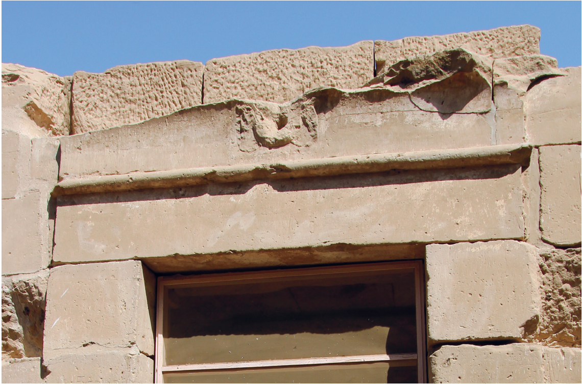
FIG. 16. Corniche de la porte d'entrée du temple du Qasr el-Agouz à Gournah. Cet exemple montre un intéressant état d'inachèvement. On peut constater que le disque et les uraei sont sculptés avant même la mise en place et la taille des cannelures et des ailes.
