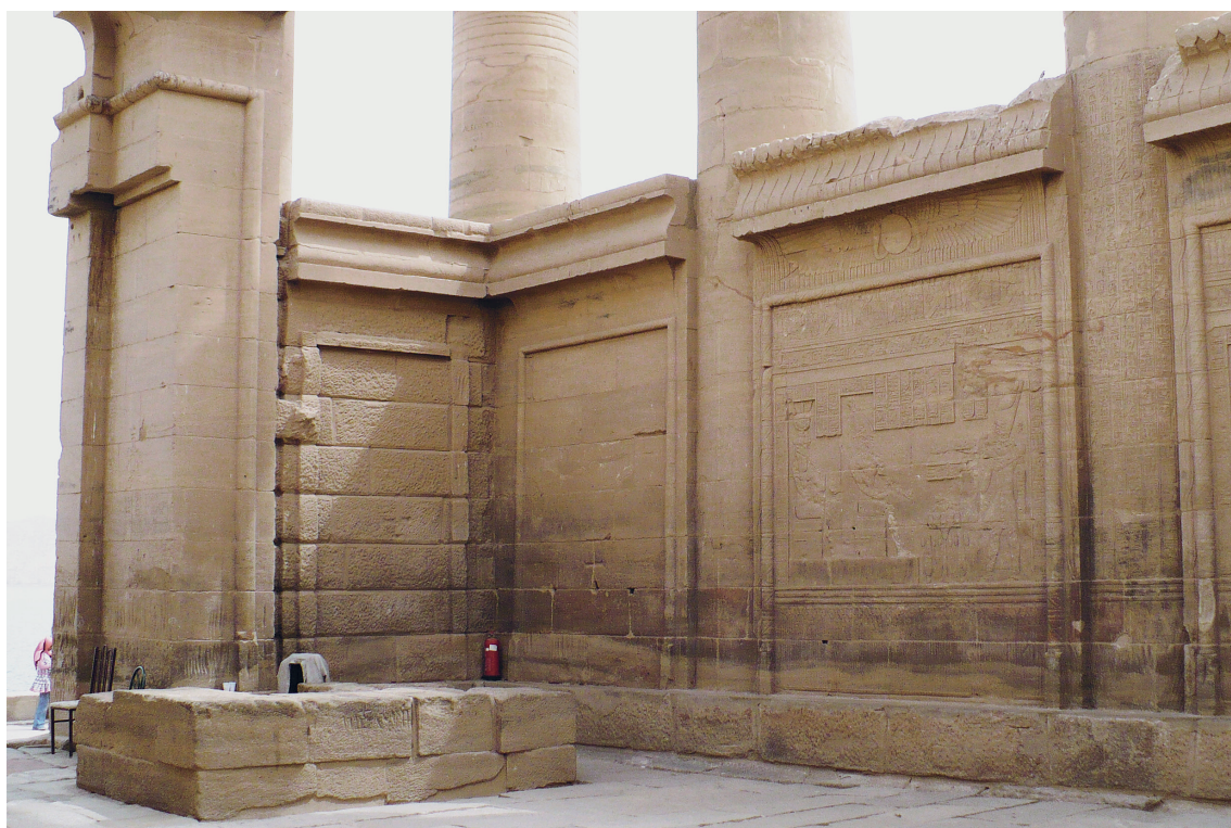
FIG. 14. Trois états différents de finition de corniches sur le kiosque de Trajan à Philae. La première est simplement épannelée, la seconde est parfaitement ravalée et prête à être décorée. La troisième est achevée. On distingue ici clairement deux étapes essentielles dans le processus : la taille de la pierre selon une géométrie parfaite, puis la taille en creux des cannelures et du disque ailé. On remarquera sur ce monument que le disque et les uraï ne sont pas en relief, mais dans le même plan que la gorge.
