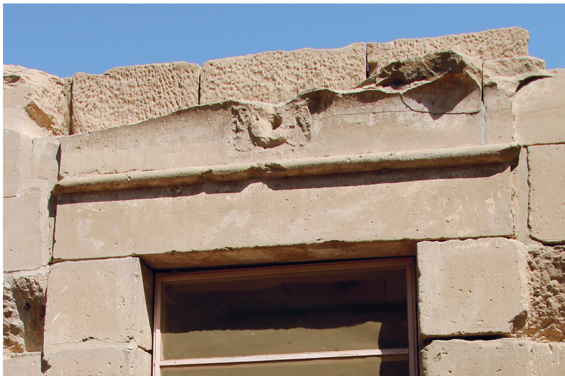
FIG. 16. Corniche de la porte d'entrée du temple du Qasr el-Agouz à Gurna. Cet exemple montre un intéressant état d'inachèvement. On peut constater que le disque et les uraei sont sculptés avant même la mise en place et la taille des cannelures et des ailes.
