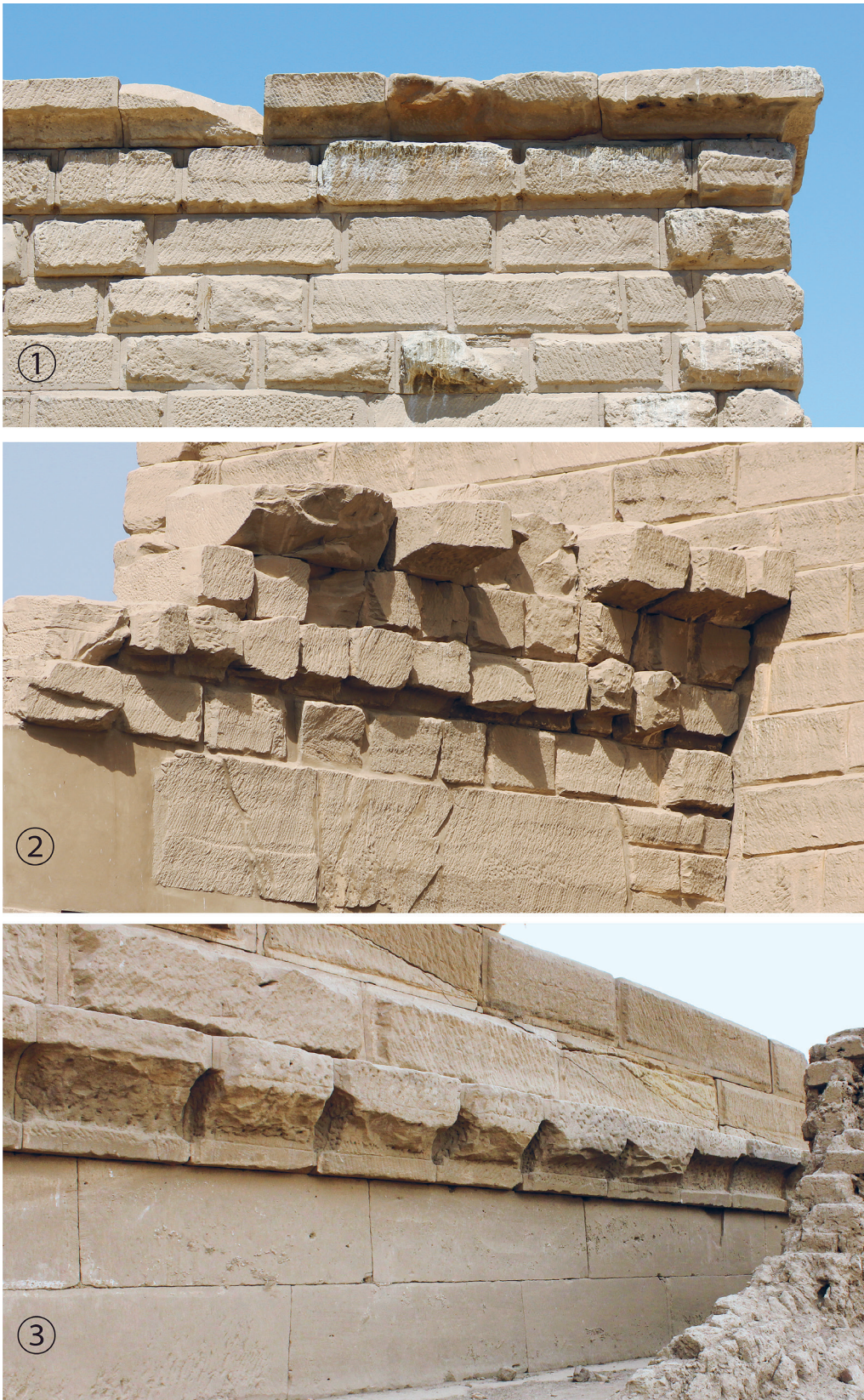
FIG. 13. État de corniches après la pose des blocs : temple de Deir Chelouit (1), portique bubastide à Karnak (2), temple d'Opet (3).
