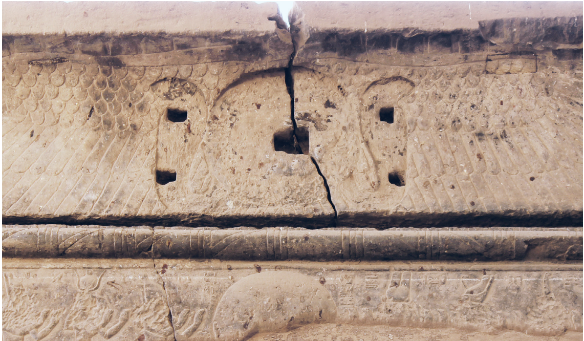
FIG. 10. Corniche de la porte d'entrée du sanctuaire de la barque du temple de Khonsou à Karnak. Les uræi et le disque solaire étaient dans ce cas taillés dans des pièces rapportées – peut-être en bois – qui étaient fixées à de la corniche à l'aide de tenons et de mortaises.
