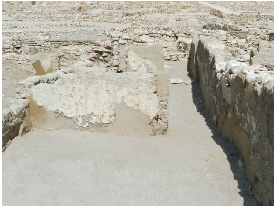
FIG. 3. Murs avec enduit antique consolidé et restauré dans la maison NO XIII (pièces 1 et 2).
