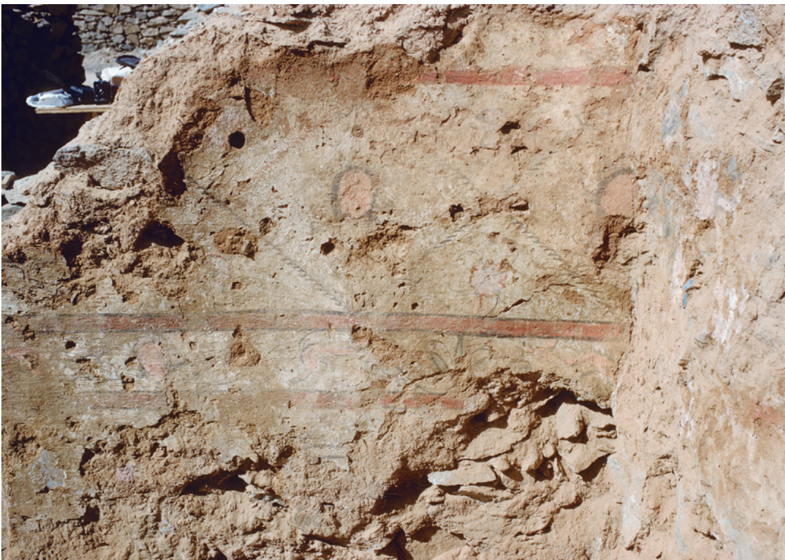
FIG. 30b. Mur ouest, ensemble, in situ .
