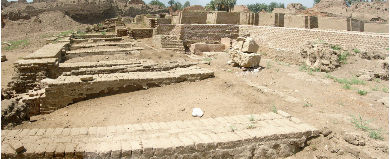
FIG. 8. Vue est-ouest du sanatorium montrant les chambres Q à W et l'installation balnéaire Ac.
