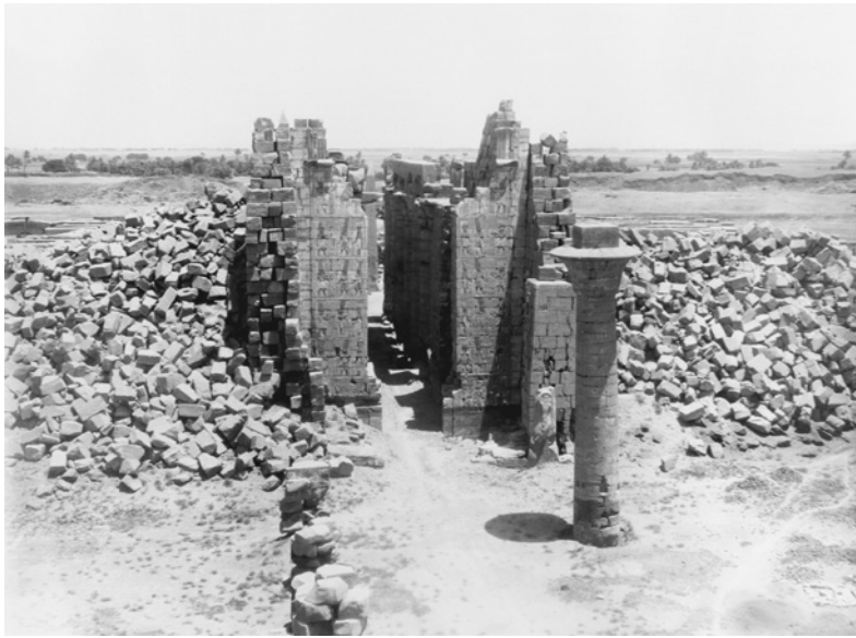
FIG. 9. Vue ancienne de la façade ouest du II e pylône.
