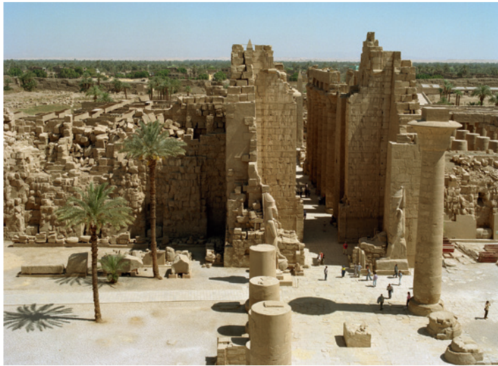
FIG. 1. Vue actuelle de la façade occidentale du II e pylône.
