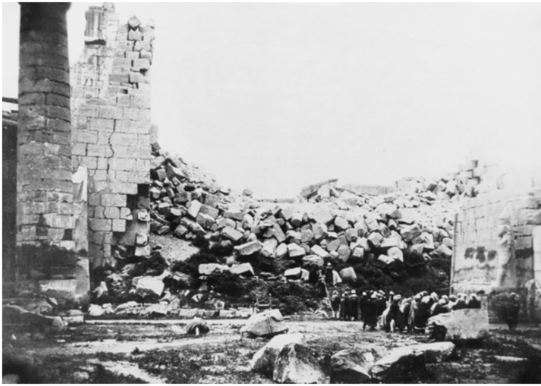
FIG. 10. Travaux de G. Legrain lors du dégagement de la façade ouest du môle sud, d'après Azim, Reveillac 2004, cliché 4-2/88.
