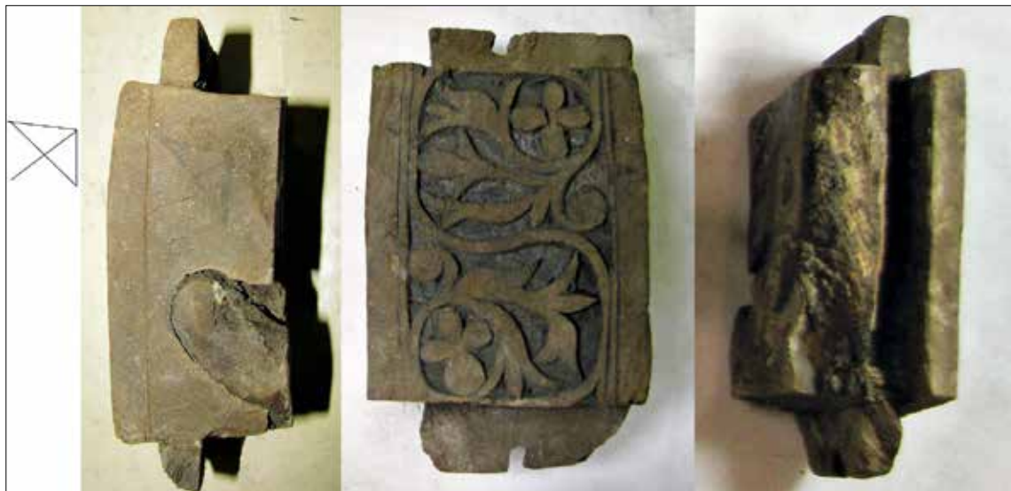
FIG. 10. Montant 6 : sur son chant droit présence d'un signe d'établissement.
