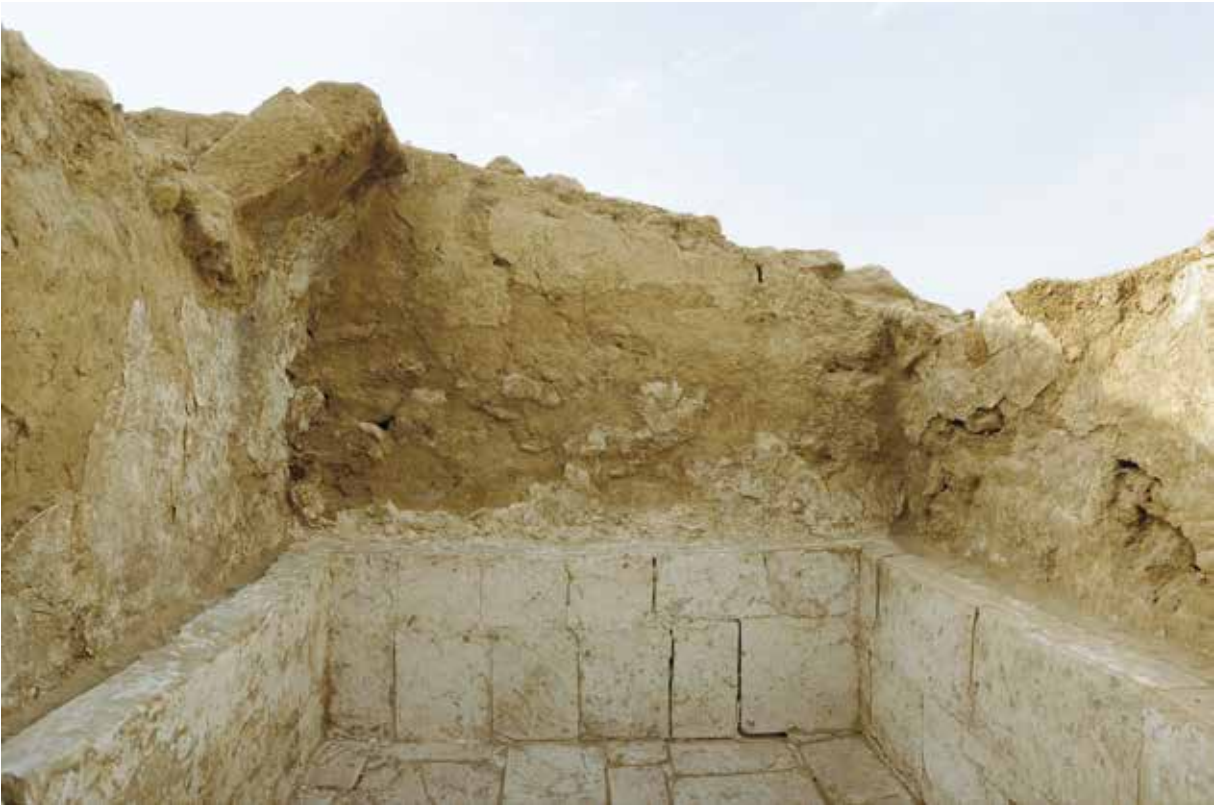
FIG. 6. Vue de détail du fouloir et de sa voûte, vers le nord. © Ifao, G. Pollin.
