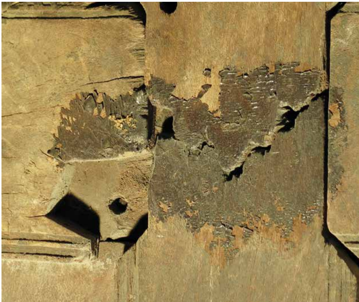
FIG. 28. Réparation ancienne (enture absente), cassure du montant 3 (présence d'un badigeon de colle animale dont on peut dire qu'il a été réalisé avec l'enture en place car il y aurait des coulures dans l'entaille).
