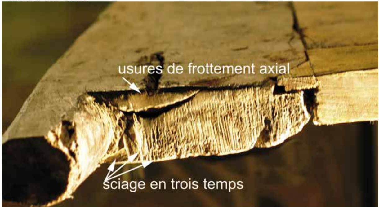
FIG. 27. Extrémité supérieure du chardonnet en lumière directe et rasante; traces d'outils.
