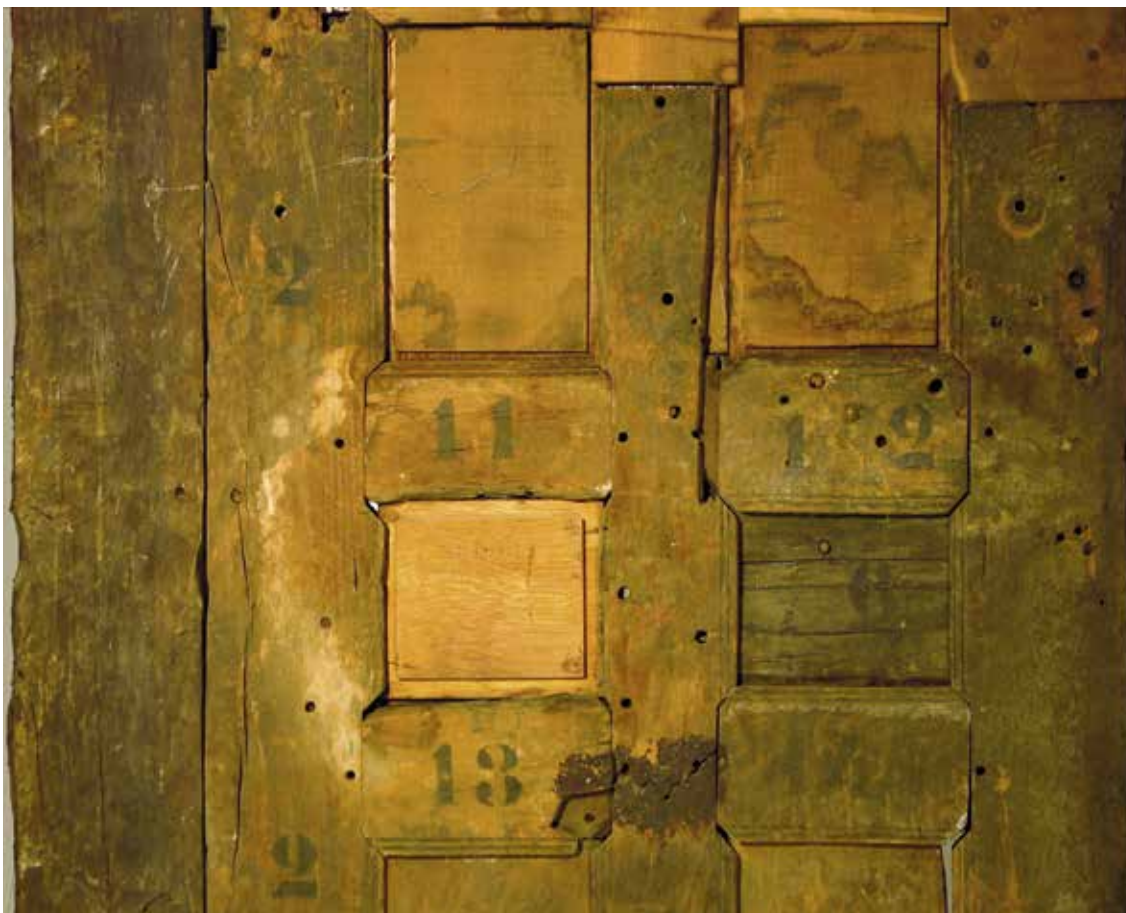
FIG. 18. Vue du contreparement, emplacement du faux-tenon médian entre le chardonnet et le montant 2, cassures, entaille trapézoïdale, perçages des axes de maintien des tenons-mortaises (le remontage est moderne, 1928), autres perçages, clou, chevilles/tourillons, zone de préhension ou de fermeture.
