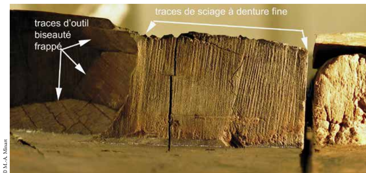
FIG. 26. Extrémité inférieure du chardonnet en lumière rasante ; traces d'outils.
