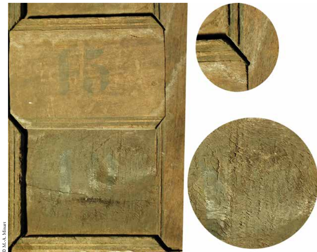
FIG. 20. Détail du contreparement : panneau 10 et traverse 15. Traces d'outil : l'épaisseur de la denture de la scie est visible dans la terminaison de la coupe d'onglet, en haut ; traces de débit par sciage, en bas.
