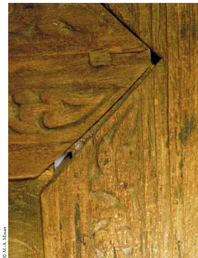
FIG. 12. Détail de l'assemblage de la traverse 11 et du montant 2.
