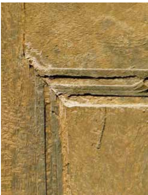
FIG. 18. Vue du contreparement, emplacement du faux-tenon médian entre le chardonnet et le montant 2, cassures, entaille trapézoïdale, perçages des axes de maintien des tenons-mortaises (le remontage est moderne, 1928), autres perçages, clou, chevilles/tourillons, zone de préhension ou de fermeture.
