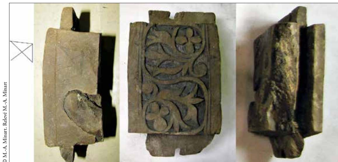
FIG. 10. Montant 6 : sur son chant droit présence d'un signe d'établissement.
