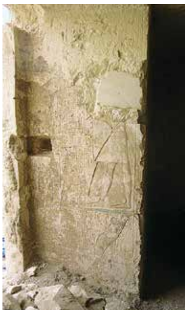
FIG. 3. Embrasure de la porte d'entrée de la tombe TT 364. Photo S. Emerit (voir doc. 8).
