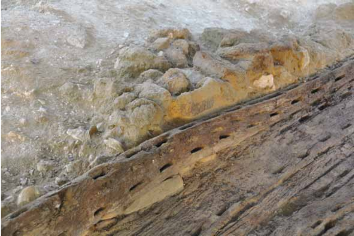
FIG. 16. Détail du mur sud de la fosse de la barque.
