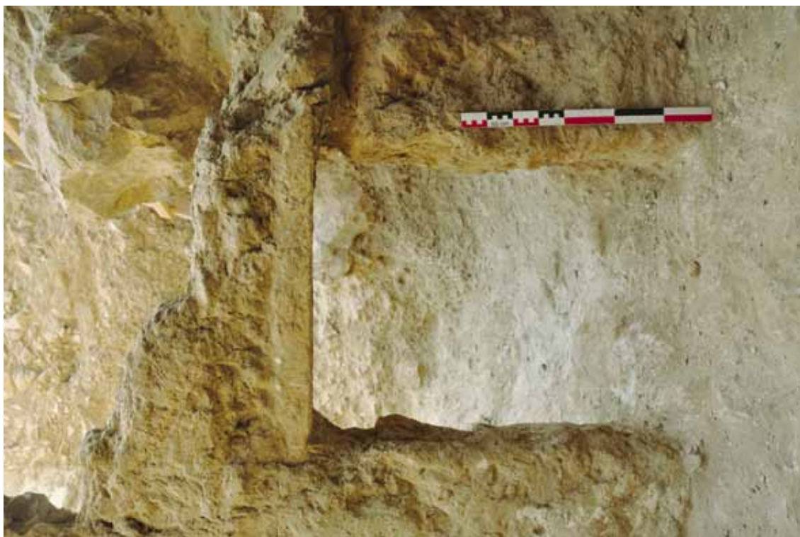
FIG. 9. Entrée du magasin au nord du puits de Mo6.
