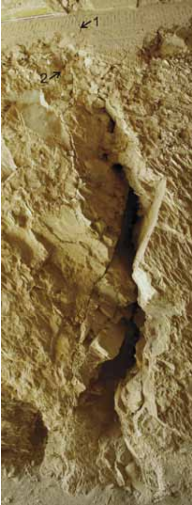
FIG. 15. Fracture ouverte dans la salle longue de la TT 71. Flèche 1, jeu post-pharaonique de la fracture; flèche 2, réparation avec des éclats de calcaire appliqués au mortier.
