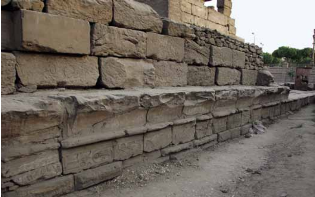
FIG. 4. Estrade à corniche à gorge du temple d'Amenhotep III à Louxor (photo R. Preys).
