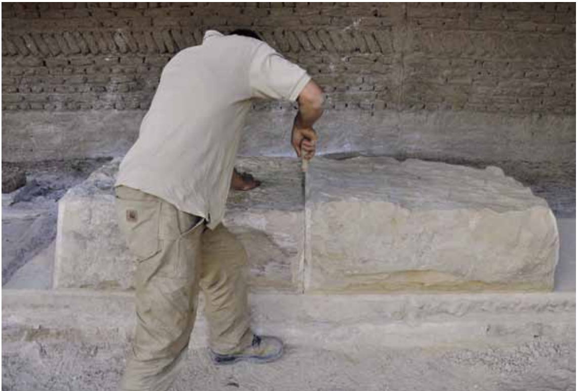
FIG. 19. Position de l'ouvrier pendant le sciage vertical. La scie, encore en position verticale, approche de la fin du joint transversal; elle va progressivement être rabattue vers une position horizontale afin de commencer sa descente dans le joint montant.
