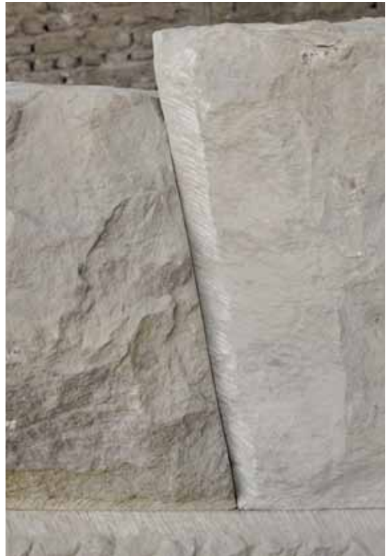
FIG. 20. Le joint après sciage et resserrement. Remarque la petite trace de scie sur le lit d'attente, à la base du joint vertical, recouverte par le bloc de droite.
