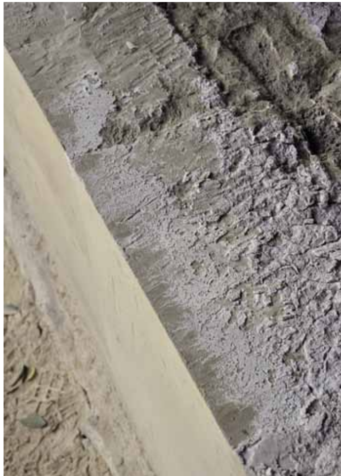
FIG. 29. Répartition du coulis sur le lit d'attente. On peut observer qu'il s'est parfaitement réparti dans le joint horizontal et comble les plus infimes dépressions du lit.
