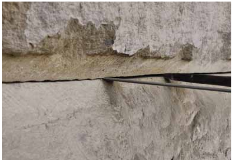
FIG. 23. Au centre de l'image, la scie en cours de sciage. Alors qu'au premier plan, le joint non scié présente encore un aspect non régulier et des poinçonnements, on distingue nettement en arrière du sciage que les deux bords du trait de scie sont sinueux mais strictement parallèles. En arrière-plan, un coin inséré dans le trait de scie maintient le bloc dans sa position d'origine.
