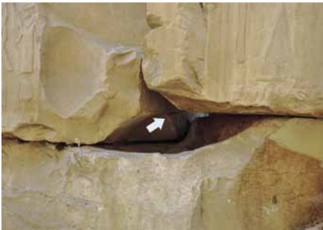
FIG. 13. « Coup de scie » laissé sur le joint vertical d'un bloc en calcaire du Netery-Menou. Ce détail prouve indiscutablement que le joint horizontal voisin a été scié.
