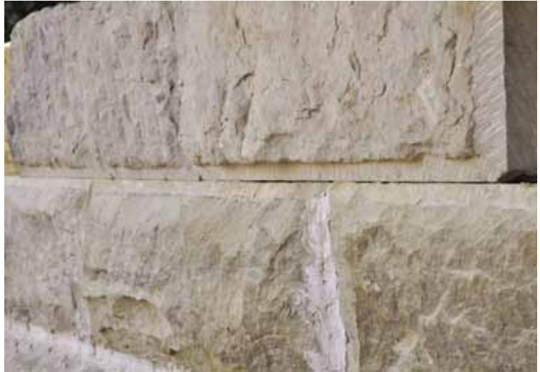
FIG. 21. Le joint horizontal avant l'ajustement par sciage.
