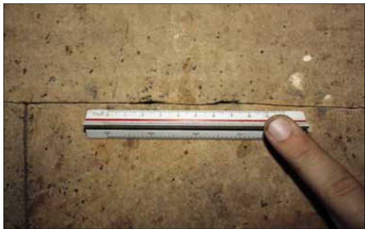
FIG. 10. Joint horizontal sinueux dans les cryptes du temple d'Opet. Dans le joint parfaitement serré on distingue deux altérations. Il pourrait s'agir là des traces de deux cales utilisées au moment du sciage.
