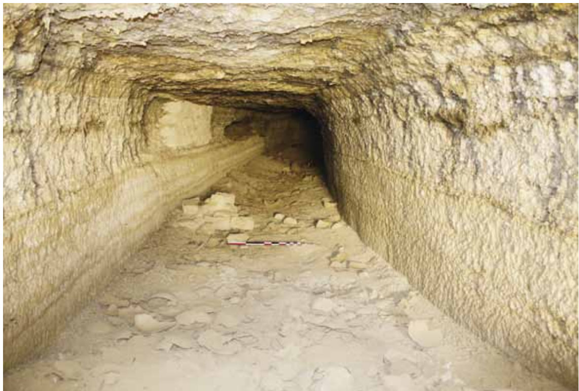
FIG. 19. Vue de l'intérieur de la galerie G2, avant la fouille. BIFAO 112 (2013), p. 399-416, Pierre Tallet, Grégory Marouard, Damien Laisney Un port de la IV e dynastie au Ouadi al-Jarf (mer Rouge). © IFAO 2026
