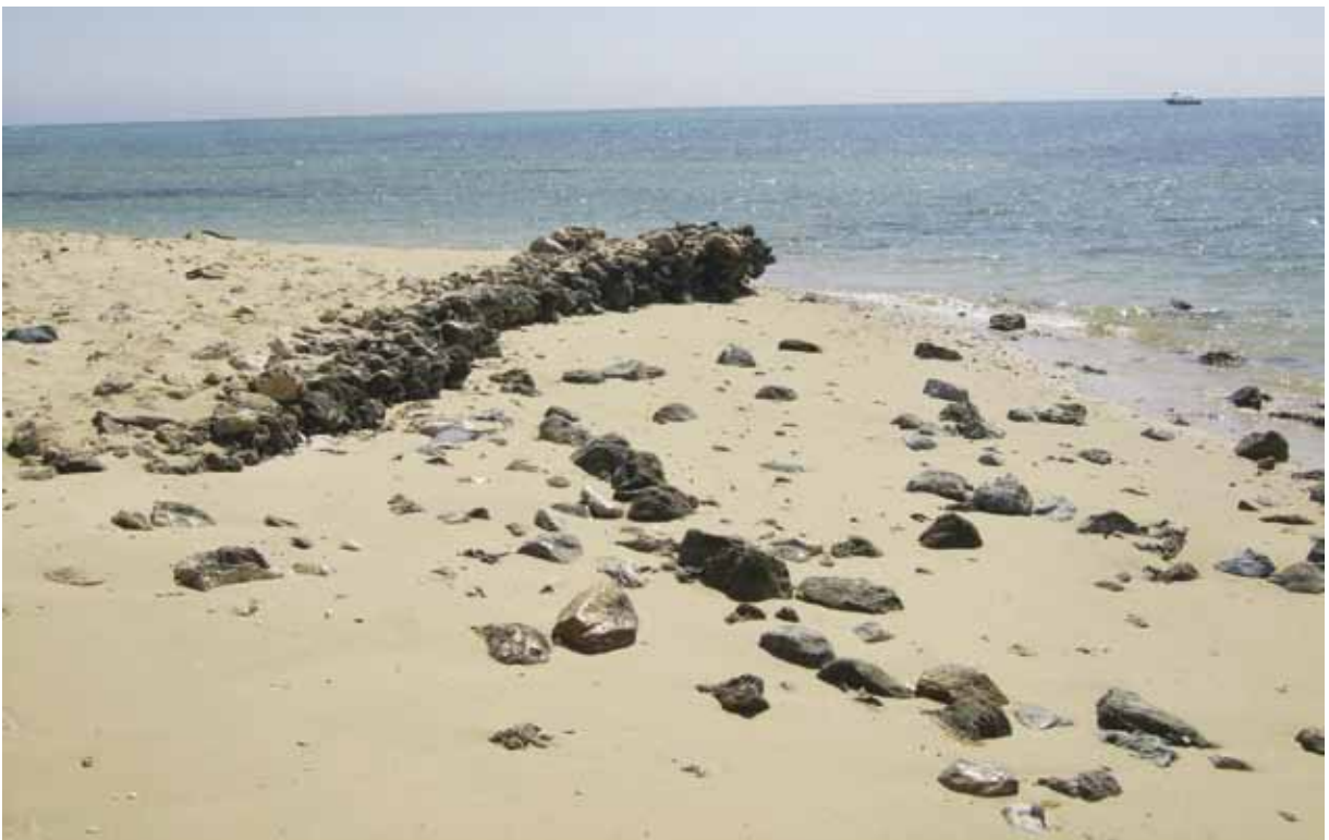
FIG. 29. Partie émergée de la jetée. BIFAO 112 (2013), p. 299-416. Pierre Tallet, Grégory Marouard, Damien Laisney Un port de la IV e dynastie au Ouadi al-Jarf (mer Rouge). © IFAO 2026
