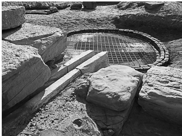
FIG. 31. Restauration de la canalisation et de la margelle du grand puits copte.
