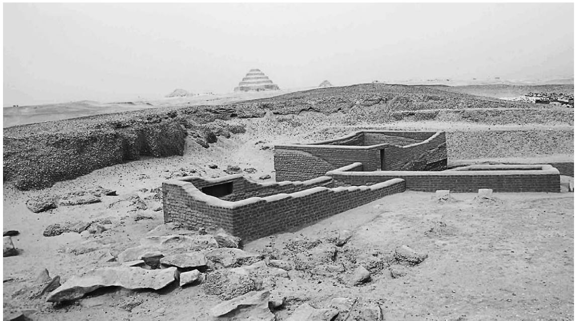
FIG. 20. Les « maisons d'éternité » des prêtres Khnoum-hotep (premier plan) et Pépy-ânkh (second plan) après les travaux de restauration ; vue du sud vers le nord.
