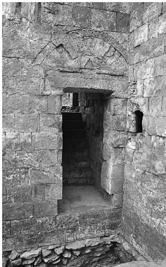
FIG. 52. Photographie de la poterne sud de Burğ al-Zafar.
