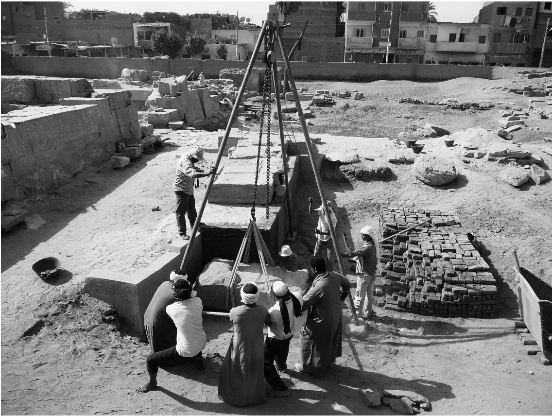
FIG. 36. Remontage d'un bloc de l'autel gréco-romain.
