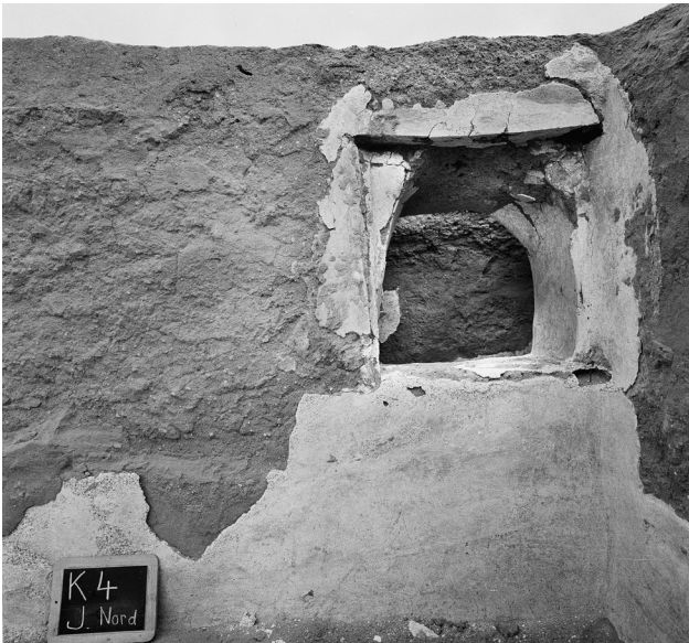
FIG. 15. Pièce J, angle nord-est, entrée du silo H 2.
