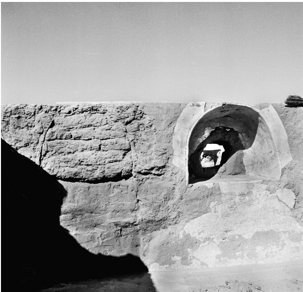
FIG. 19. Pièce O, paroi nord avec niche et dossier à gauche, porte murée vers la pièce J.
