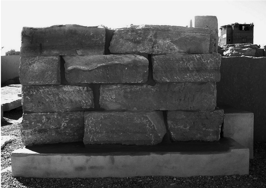
FIG. 21. Mur est de la chapelle oraculaire de Cléopâtre après remontage.
