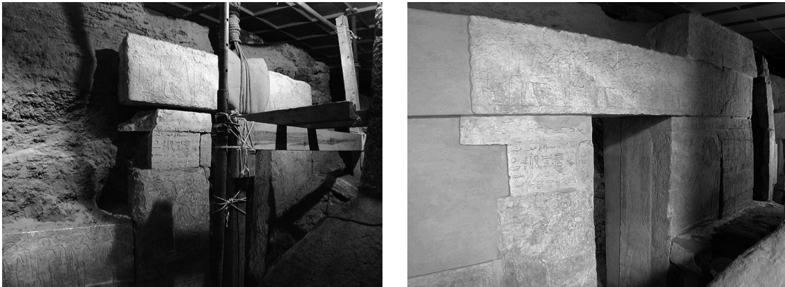
FIG. 7-8. Façade de la chapelle de Khoui pendant et après les travaux de restauration.
