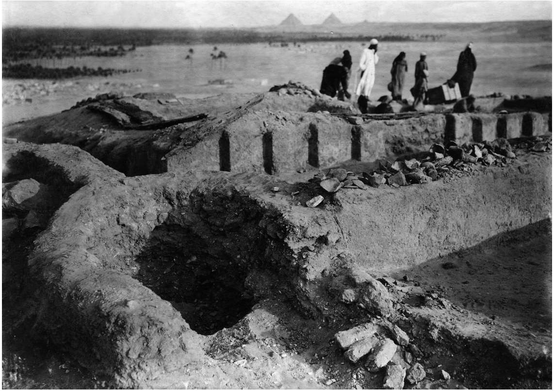
FIG. 14. Structure circulaire à l'angle de l'enceinte de la tombe MoI.
