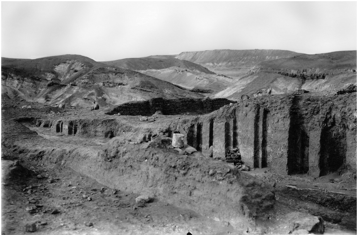
FIG. 7. Façade orientale du mastaba Mo7. Les murs en briques crues sont conservés sur une hauteur d'environ 1 m. Photo publiée dans Montet 1938, pl. XI.
