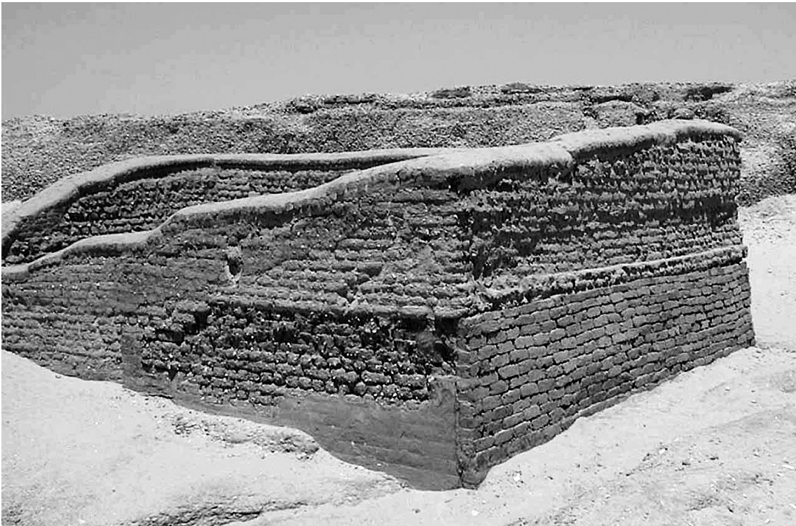
FIG. II. Saqqâra-Sud : travaux de restauration à l'extérieur du mur nord de l'enceinte en brique crue n° 1006.
