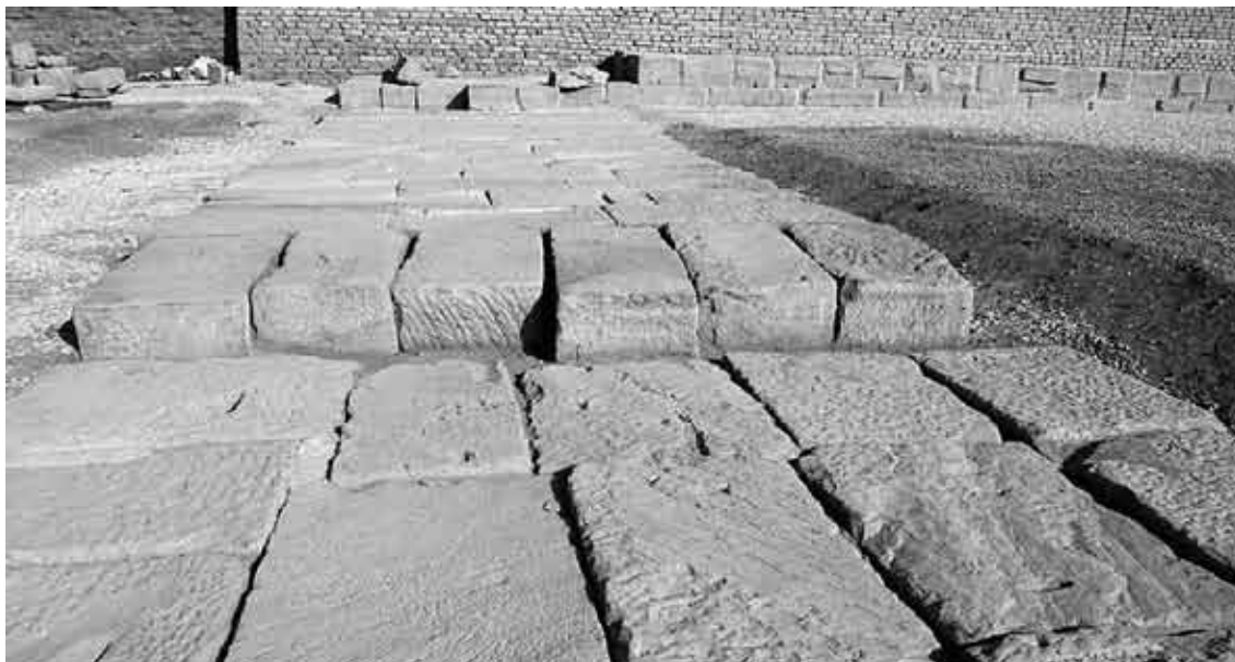
FIG. 21. Péribole nord du temple d'Hathor. Section du mur avec des blocs seulement juxtaposés.
