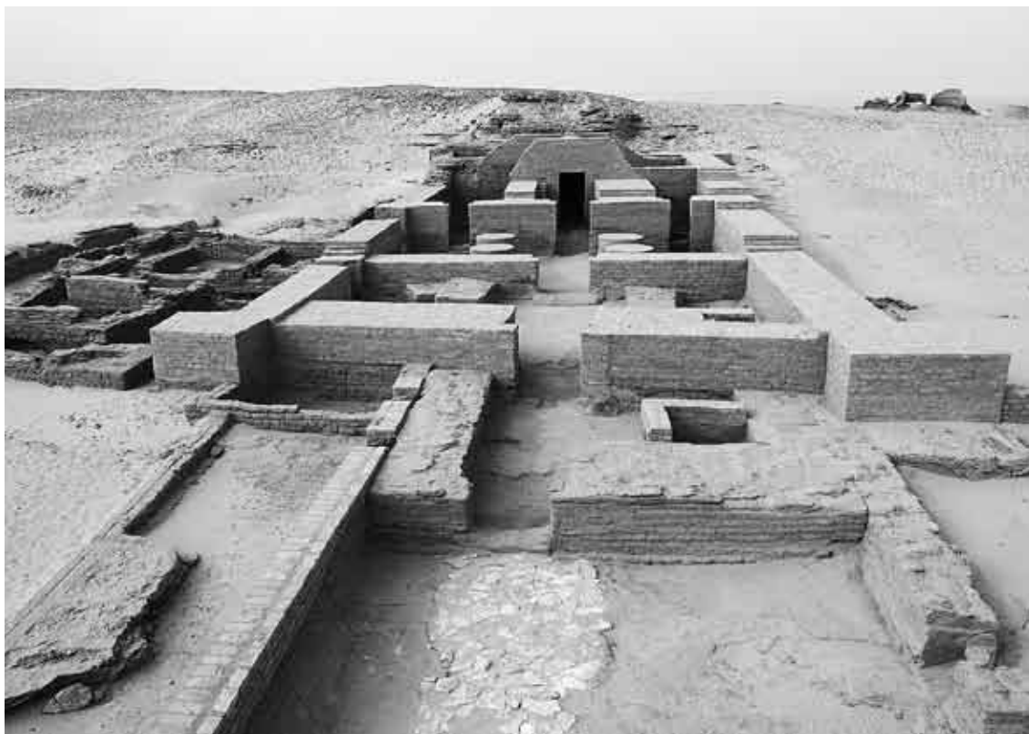
FIG. 36. Temple de 'Ayn-Manâwir après restauration.
