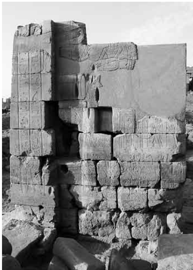
FIG. 27. Paroi intérieure du couloir d'entrée de la chapelle après restauration.
