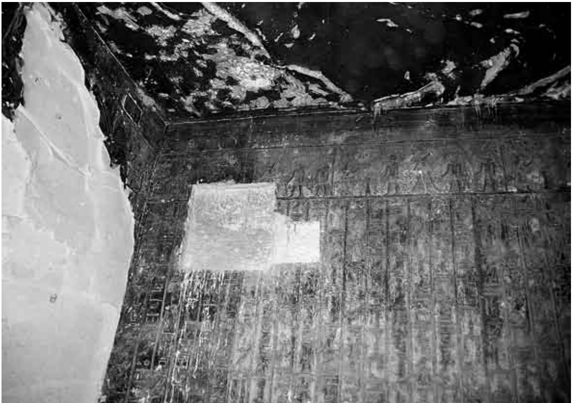
FIG. 23. S. II : suie pelliculaire et souillures sur une paroi saine. Détachements d'inserts et zones entières de l'épiderme de la pierre, postérieurs aux souillures.
