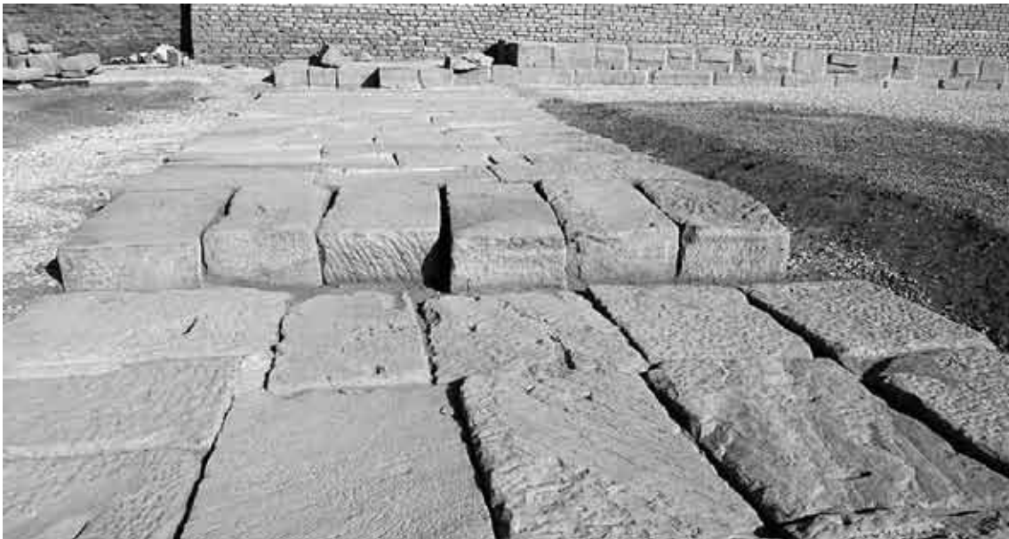
FIG. 21. Péribole nord du temple d'Hathor. Section du mur avec des blocs seulement juxtaposés.
