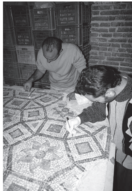
FIG. 12. Maison de la Méduse. Mosaïque de la partie nord de la salle à manger en cours de restauration.
