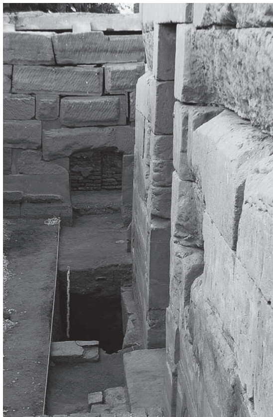
FIG. 26. Sondage au pied de la façade est du naos .
