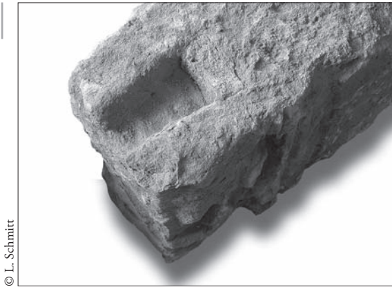
FIG. 8. Bloc TCG23 présentant une cavité de scellement en queue-d'aronde sur son lit d'attente.
