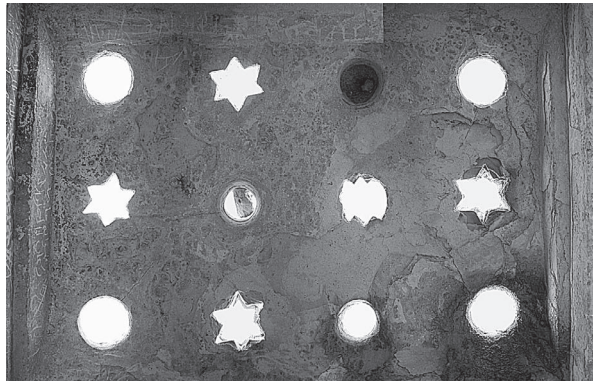
Fig. 28. Qal'at al-Guindi. Hammam : plafond à oculi de la salle chaude.
