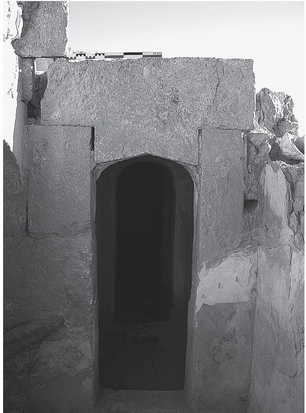
Fig. 26. Qal'at al-Guindi. Hammam : corridor d'accès à la salle chaude.
