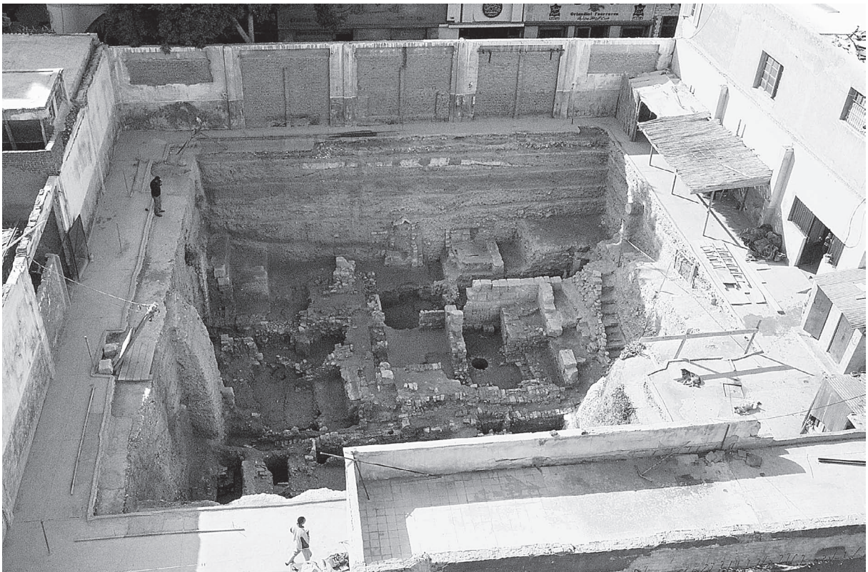
Fig. 13. Alexandrie. Patriarcat grec orthodoxe. Vue générale du chantier (© Fr. Choël, archives CEA).
