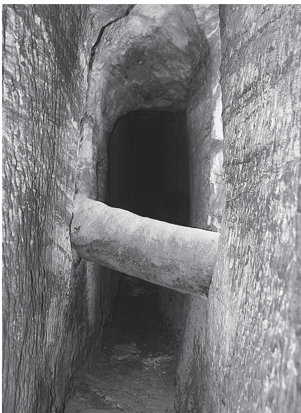
Fig. 6. Croisement des qanâts MQ5 et MQ4. Un tuyau en céramique permet aux eaux collectées dans la qanât MQ4 de franchir la galerie de MQ5, creusée plus bas.
