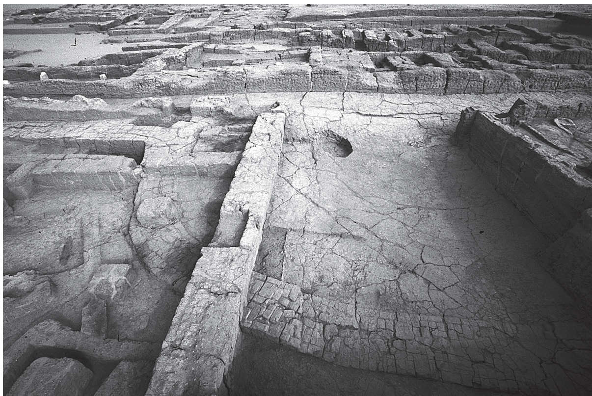
Fig. 9. 'Ayn-Asil. Palais des gouverneurs du règne de Pépy II. Arase du mur d'enceinte premier; vue W/E.
