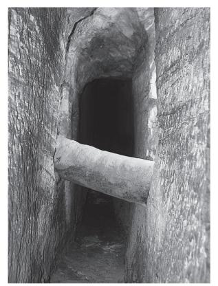
Fig. 6. Croisement des qanâts MQ5 et MQ4. Un tuyau en céramique permet aux eaux collectées dans la qanât MQ4 de franchir la galerie de MQ5, creusée plus bas.
