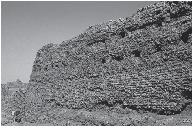
Fig. 33. Seconde enceinte, côté est : détail du doublement avec assises courbes.
