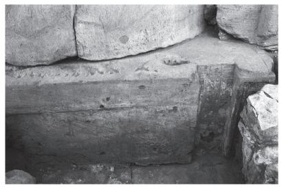
Détail nord de la surface ravalée de l'assise de grès préparée pour être plaquée contre la construction calcaire avec à droite le motif d'encadrement d'un mur d'entrecolonnement.
