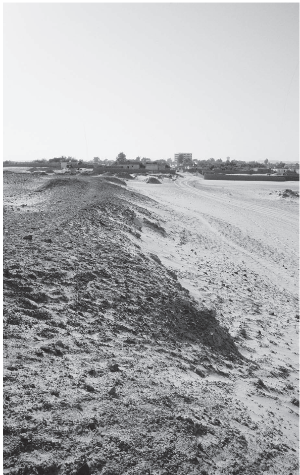
Fig. 11. Talus sud (vue depuis l'angle sud-ouest) (1999).
