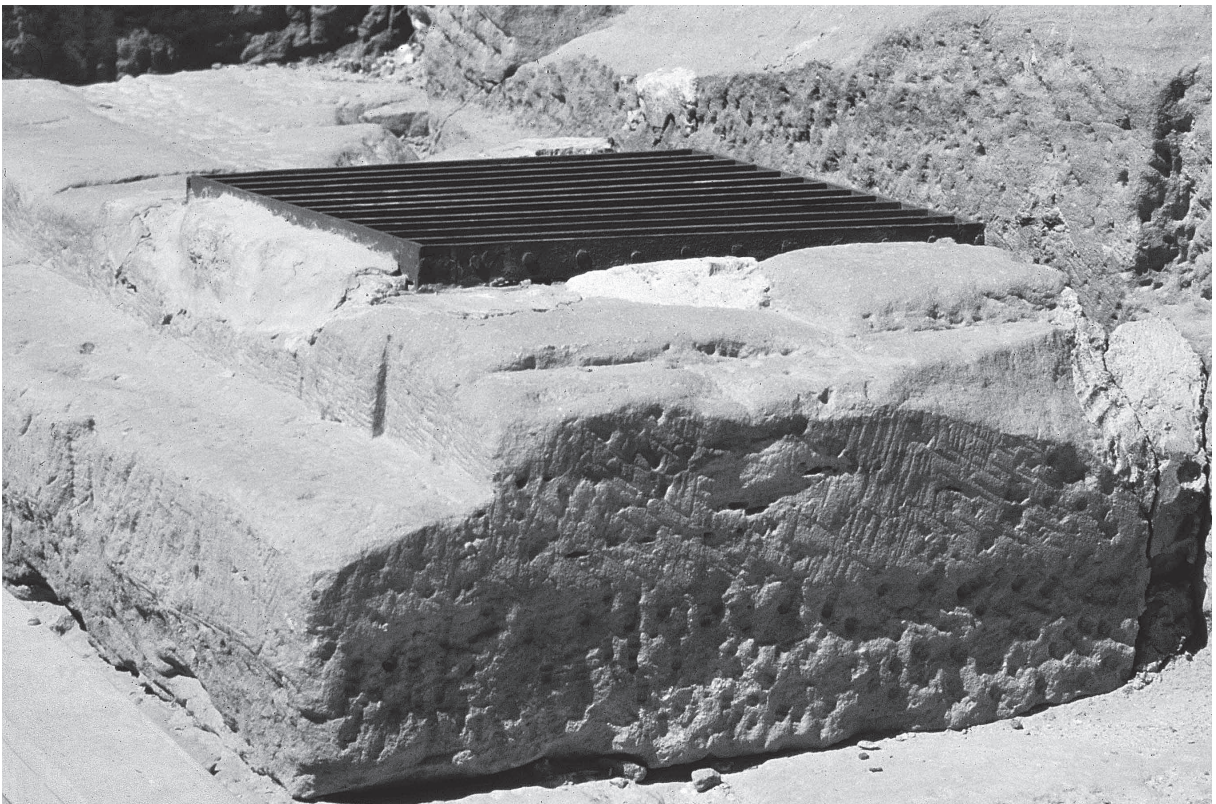
Fig. 32. Détail de la partie subsistante (inférieure) du bloc de parement avec l'ouverture exposée au sud.
