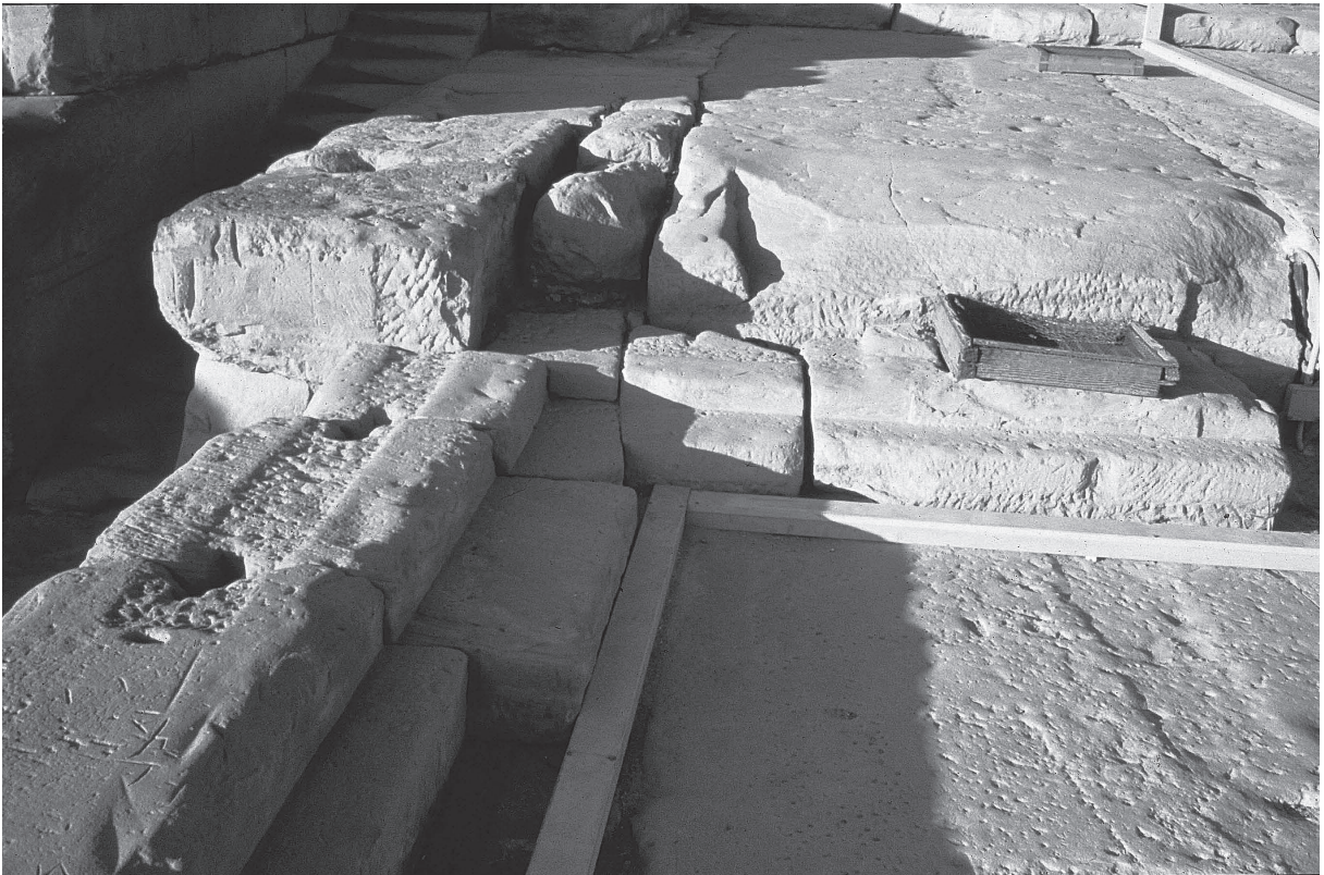
Fig. 31. Terrasses : vue de l'emplacement de l'éclairage latéral sud de la salle des offrandes avec le canal de mortier d'un muret secondaire sur la remontée bordant la terrasse.
