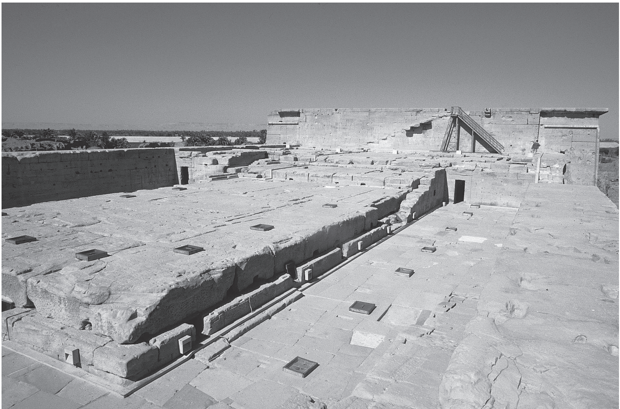
Fig. 2. Vue de la terrasse avec les dispositifs d'éclairage : (1) dispositifs zénithaux, (2) dispositifs latéraux.
