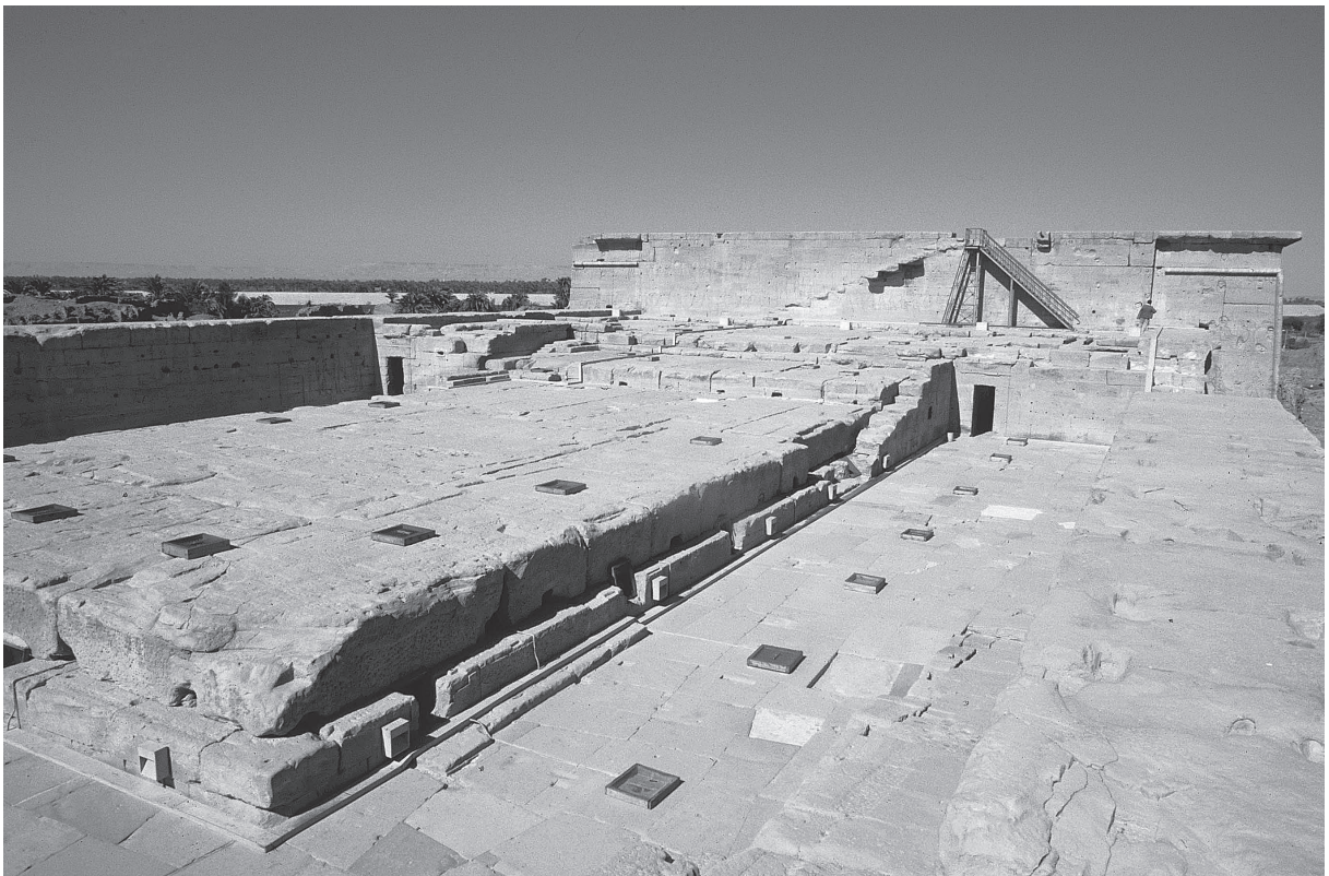
Fig. 2. Vue de la terrasse avec les dispositifs d'éclairage : (1) dispositifs zénithaux, (2) dispositifs latéraux.
