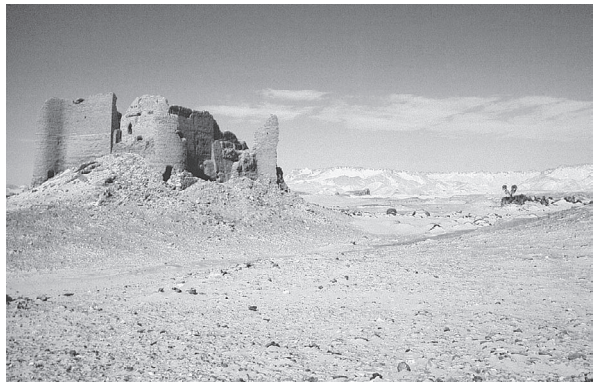
17. Ain Labakha, vue générale (photo Reddé).
