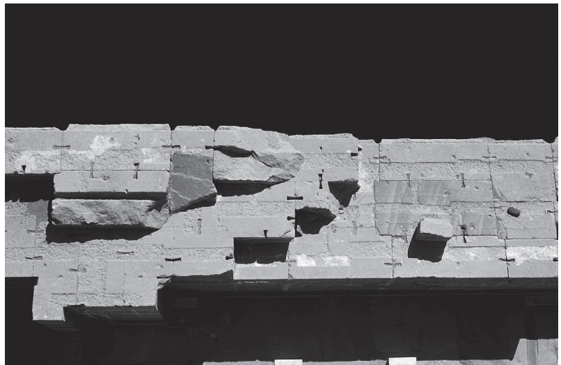
Fig. 7. Vue des assises supérieures du mur péribole à l'est du pronaos.
