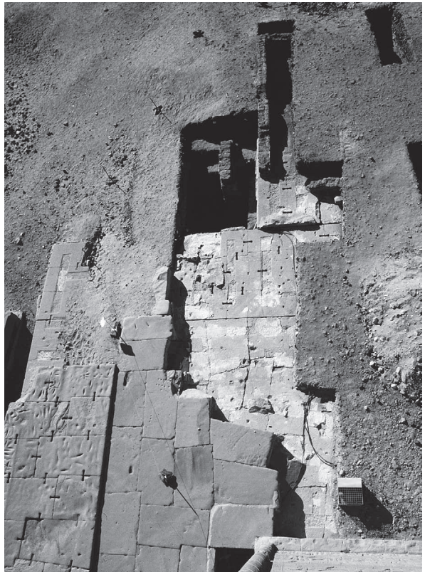
Fig. 3. Sondage 97.I. Vue du radier de dallage et de la fondation du mur péribole.
