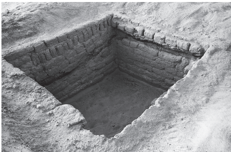
Fig. 46. Branche MQ-5'. L'un des très grands regards carrés. Des restes de poutraison sont visibles dans la maçonnerie de briques crues.
