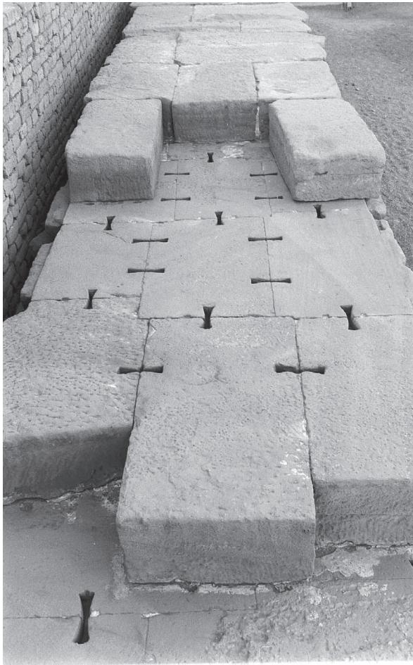
Fig. 1. Dendera, temple d'Hathor. Détail de l'agrafage d'un bloc sur le mur péribole en pierre (cliché Alain Lecler, Ifao).
