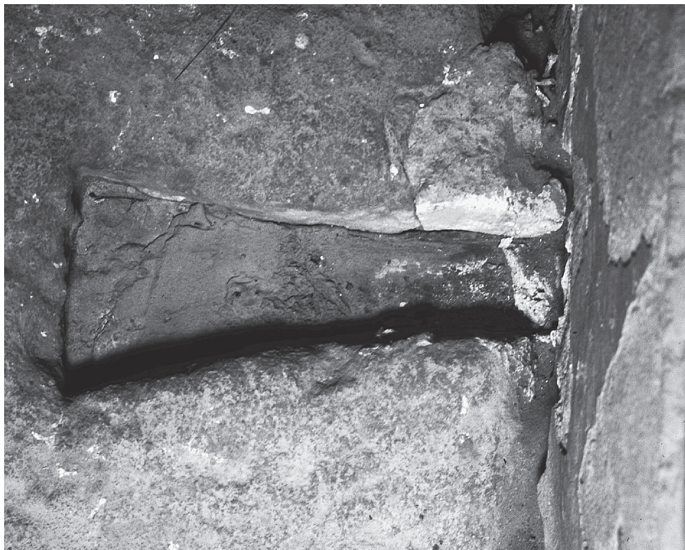
Fig. 5. Mortaise remplie de plomb.
