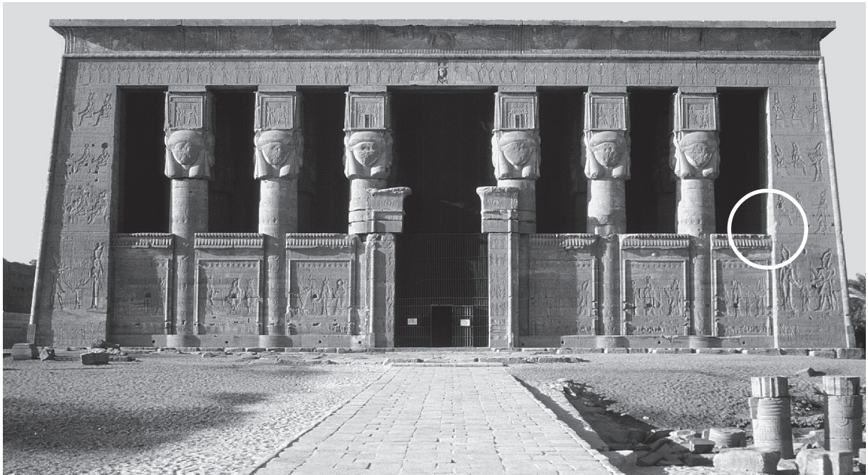
Fig. 4. Dendera, temple d'Hathor. Façade nord du pronaos et localisation de la mortaise remplie de plomb.
