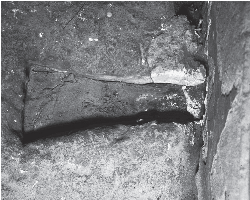
Fig. 5. Mortaise remplie de plomb.
