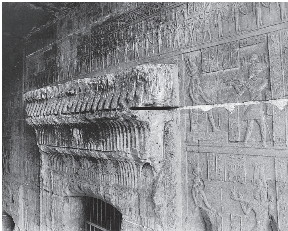
Fig. 24. Dendera, temple d'Isis, détail du joint entre les linteaux au-dessus de l'entrée dans la chapelle principale.
