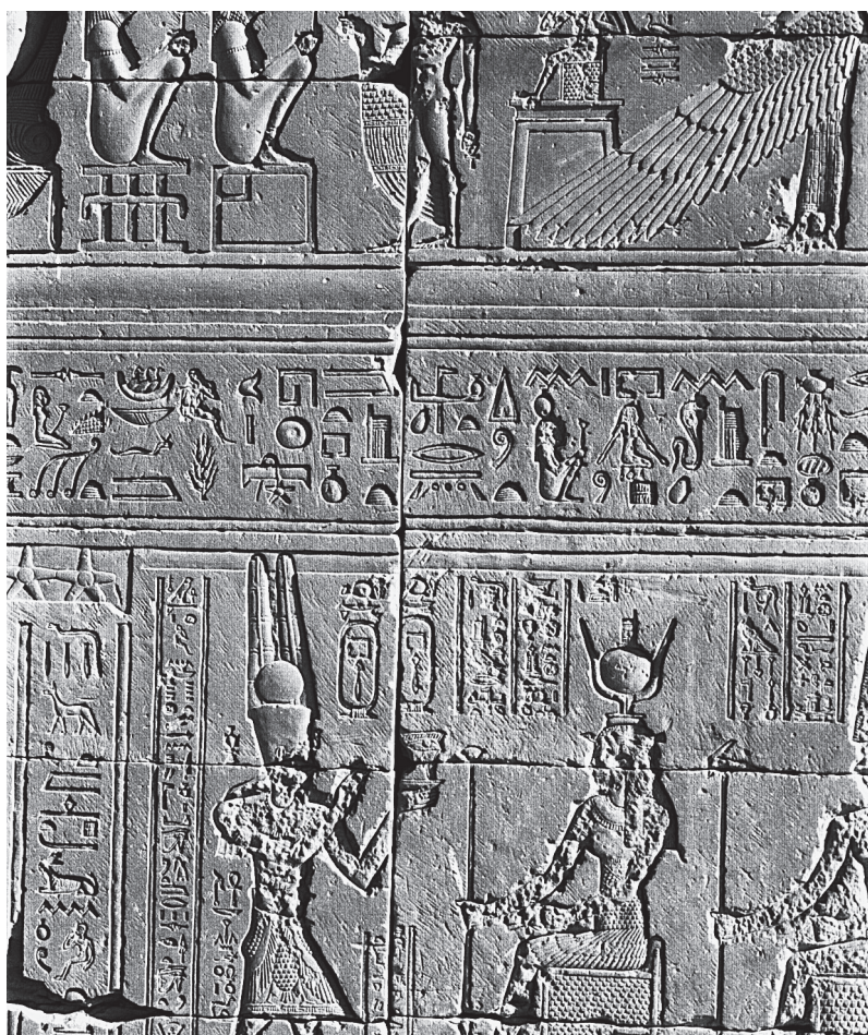
Fig. 35. Conséquences des tassements différentiels : décalage dans la continuité horizontale de l'épigraphie (cliché A. Lecler).
