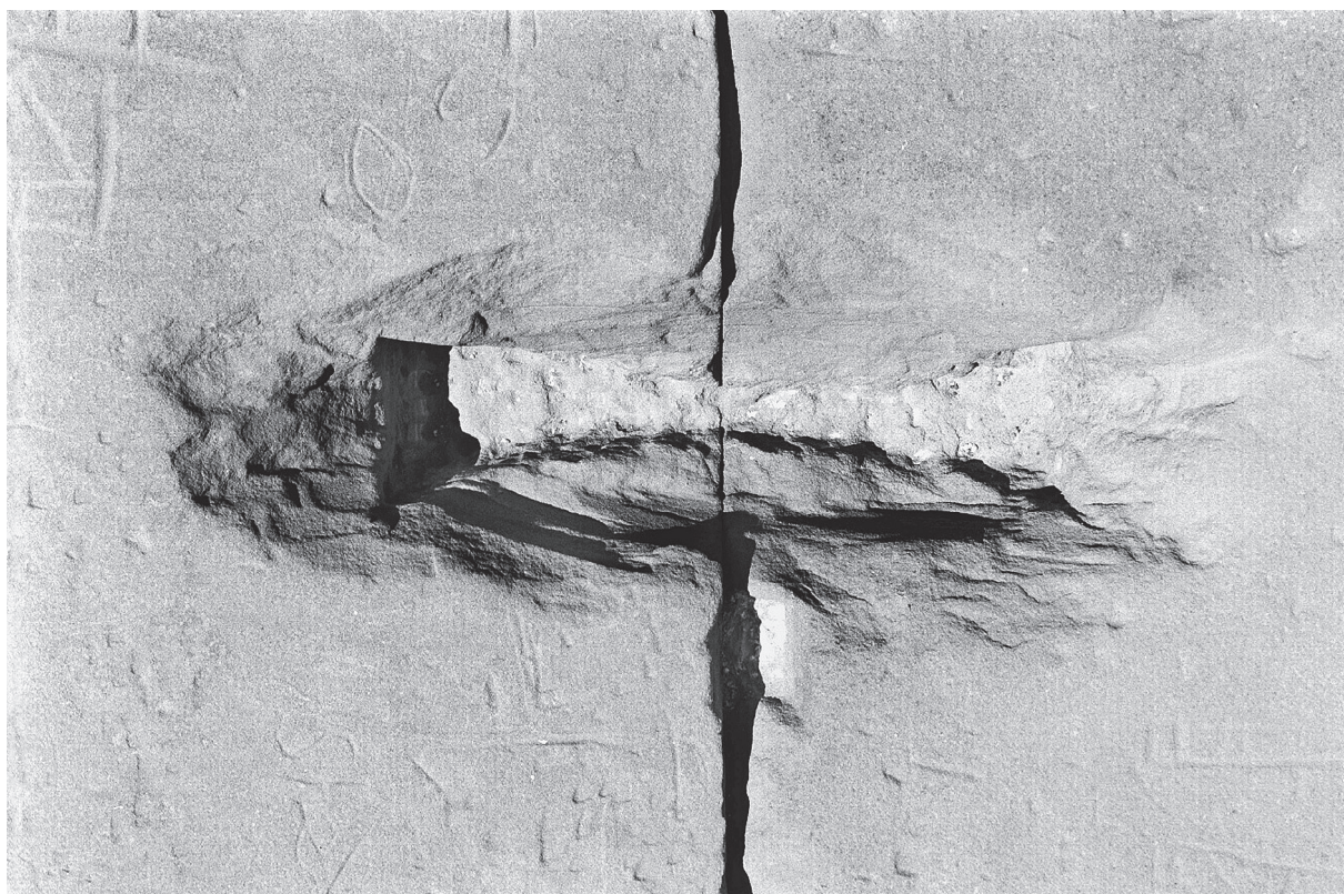
Fig. 9. Dendera, temple d'Hathor, corniche du pronaos, forme de mortaise déstructurée par l'effort de récupération d'un crampon métallique.
