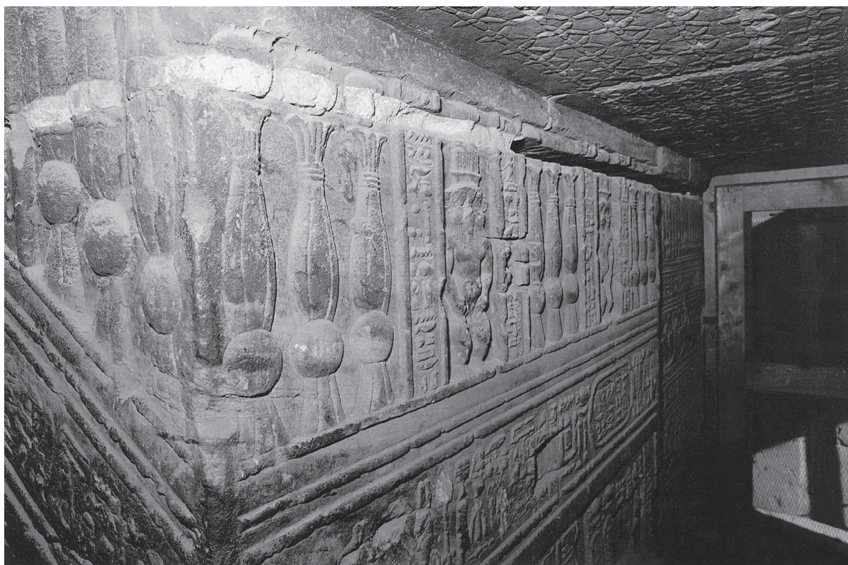
Fig. 17. Détail de la fig. 16 sur le traitement final du joint ouvert masqué par du mortier et décoré.
