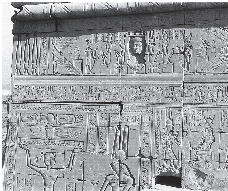
Fig. 34. Vue du joint et du vide au-dessus de la corniche (cliché A. Lecler).
