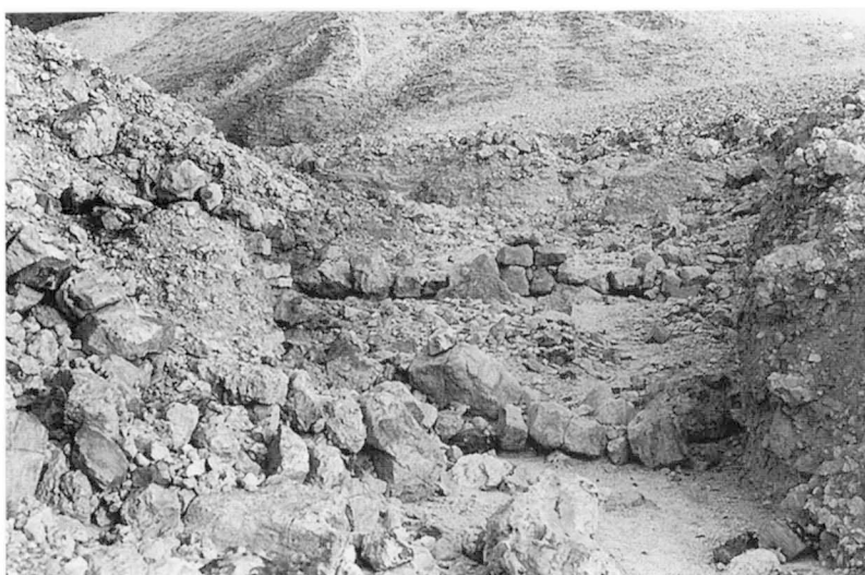
◁ b. Barrage intermédiaire (les deux murs de parement s'aperçoivent sur la gauche du cliché) ; un peu en amont un seuil fait de grosses pierres.
