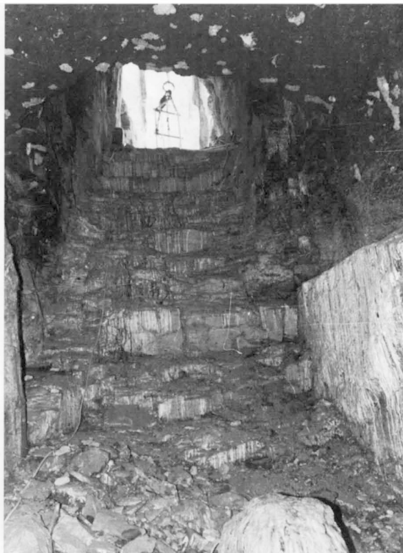
▽ b. L'escalier vu d'en bas.
