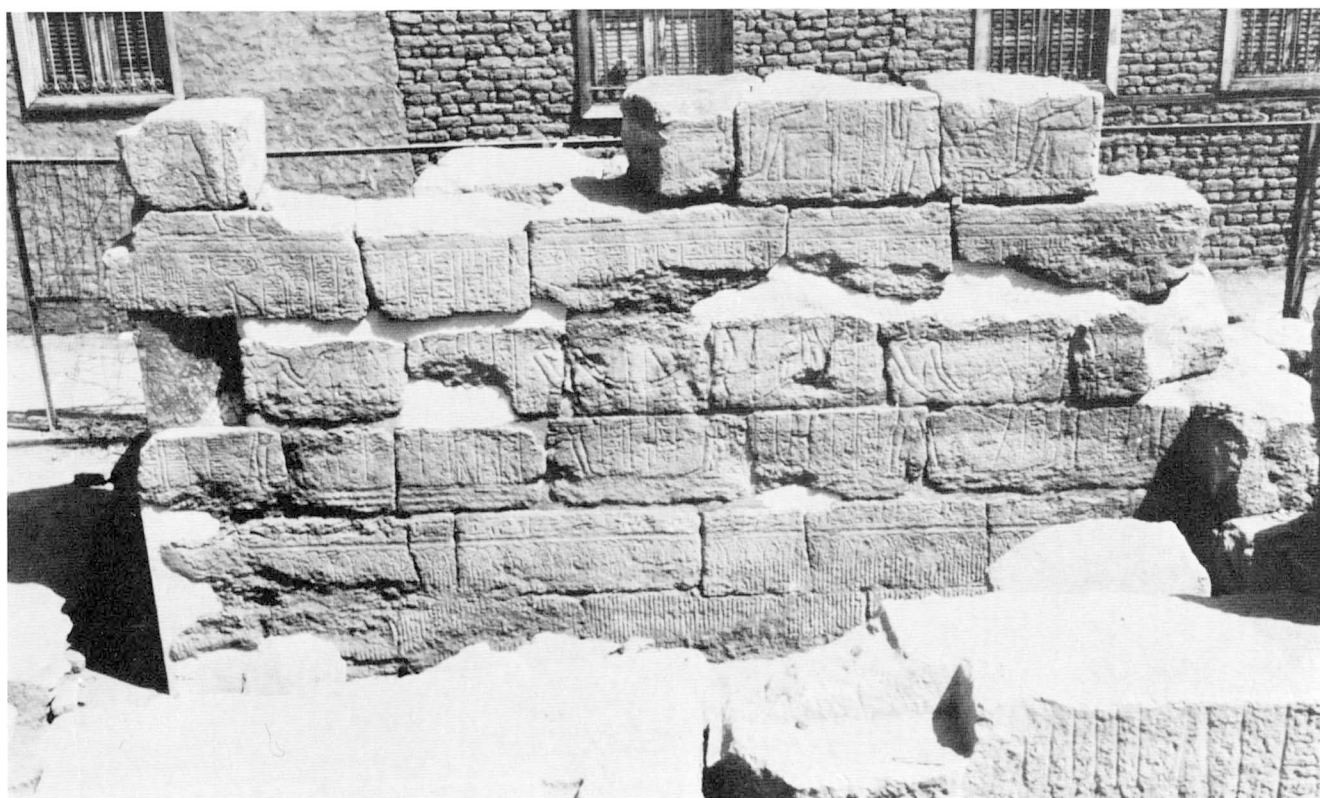
△ b. Mur E du grand vestibule après remontage des deux assises supérieures.
