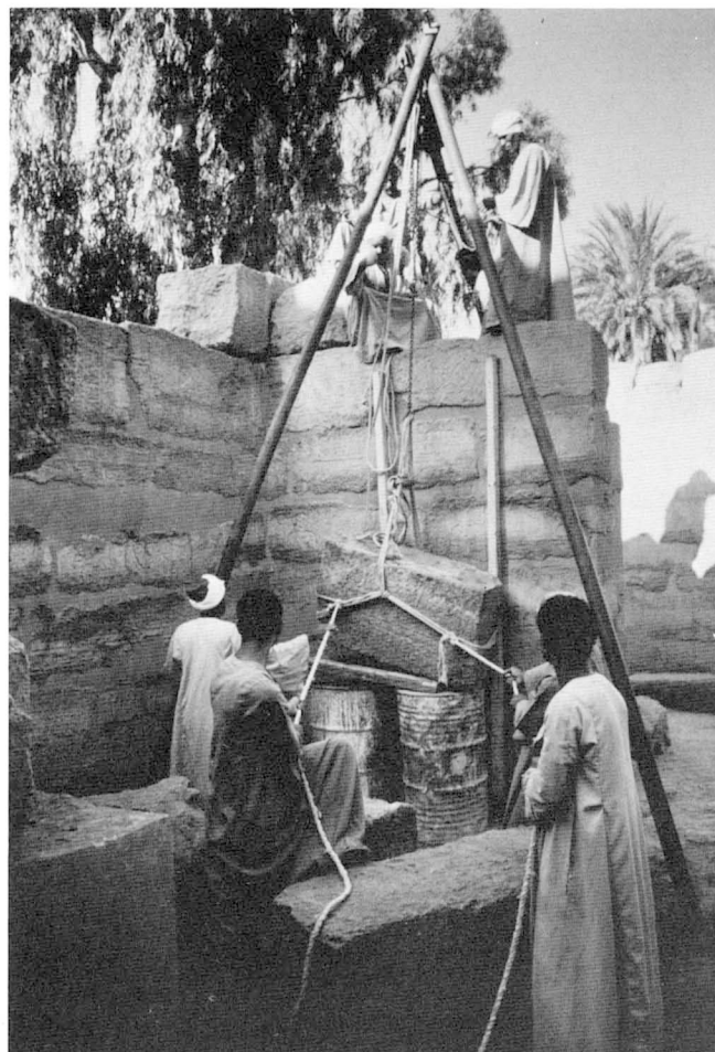
➤ a. remise en place d'un bloc au moyen de la chèvre.
