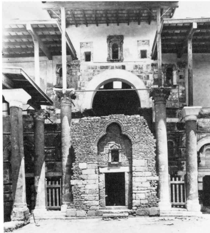
Fig. 3. La façade du sanctuaire avant la construction du mur tardif.
